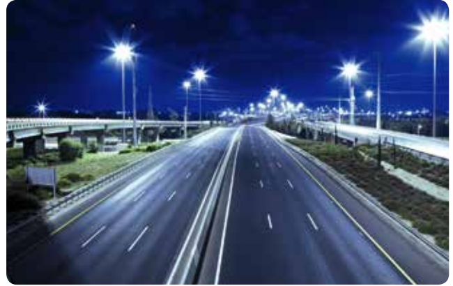
Hệ thống cáp ngầm trên đường cao tốc Underground cable system on highway
