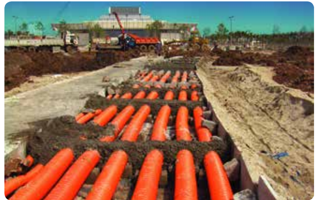
Hệ thống cáp ngầm tại các dự án đường dây cao thế 110kV - 220kV Underground cable system at 110kV – 220 kV power cable lines
