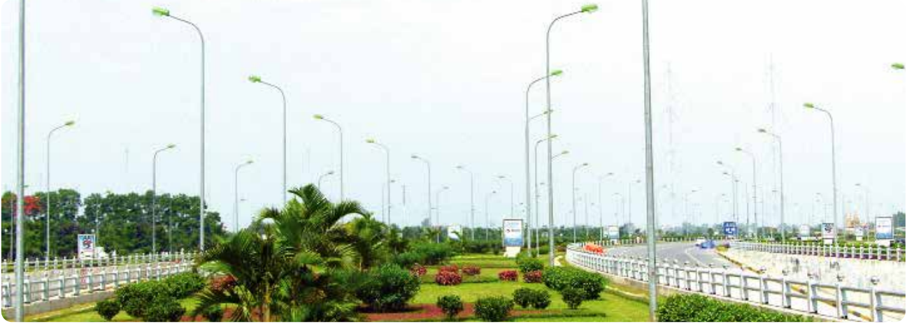
Ống BFP được sử dụng trong hệ thống chiếu sáng đường Láng - Hoà Lạc BFP are used in the lighting System on Láng - Hoa Lac Road
