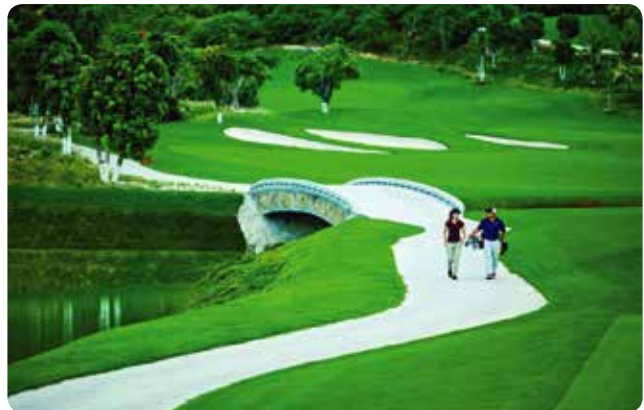
Hệ thống cáp ngầm tại các sân golf Underground cable system in golf-court
